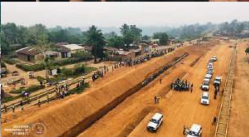
Sites PK 706 Pendant les travaux
