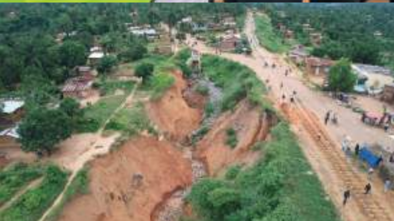
Sites PK 706 Avant les travaux
